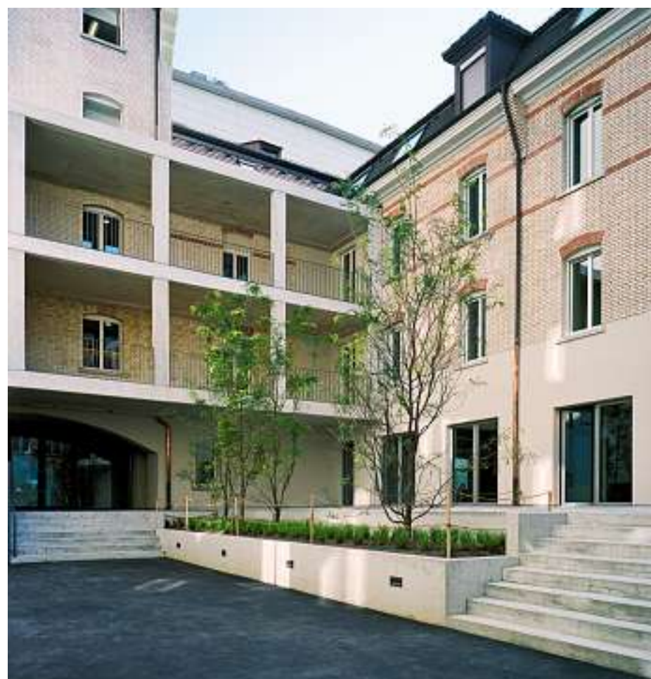
Setzt ein markantes gestalterisches Zeichen: die offene Betonkonstruktion der neuen Balkone im Innenhof.
